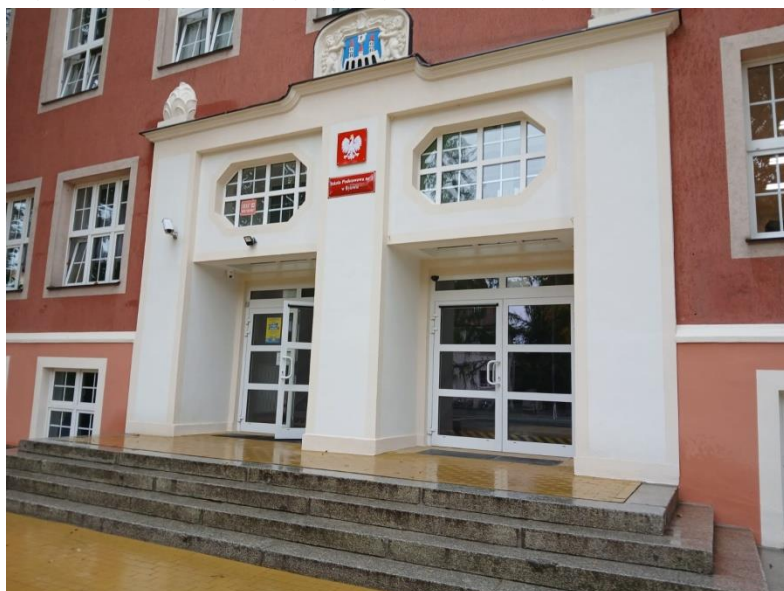
Naprawa części elewacji przy wejściu do szkoły
