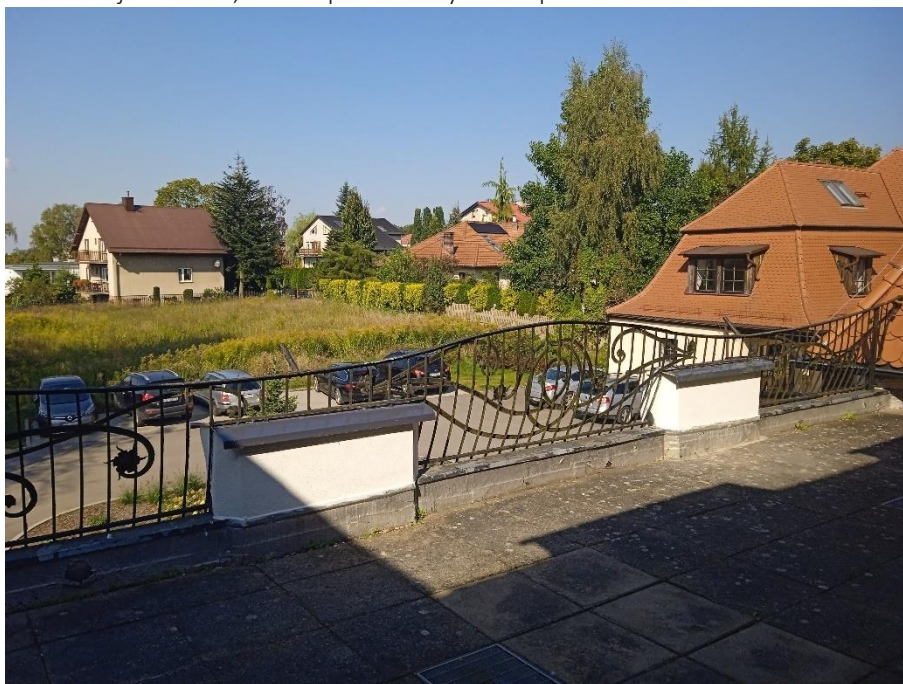
Renowacja kolumn, tarasu przed budynkiem przedszkola
