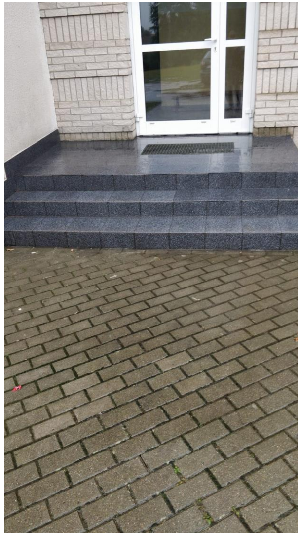
Remont schodów zew.
